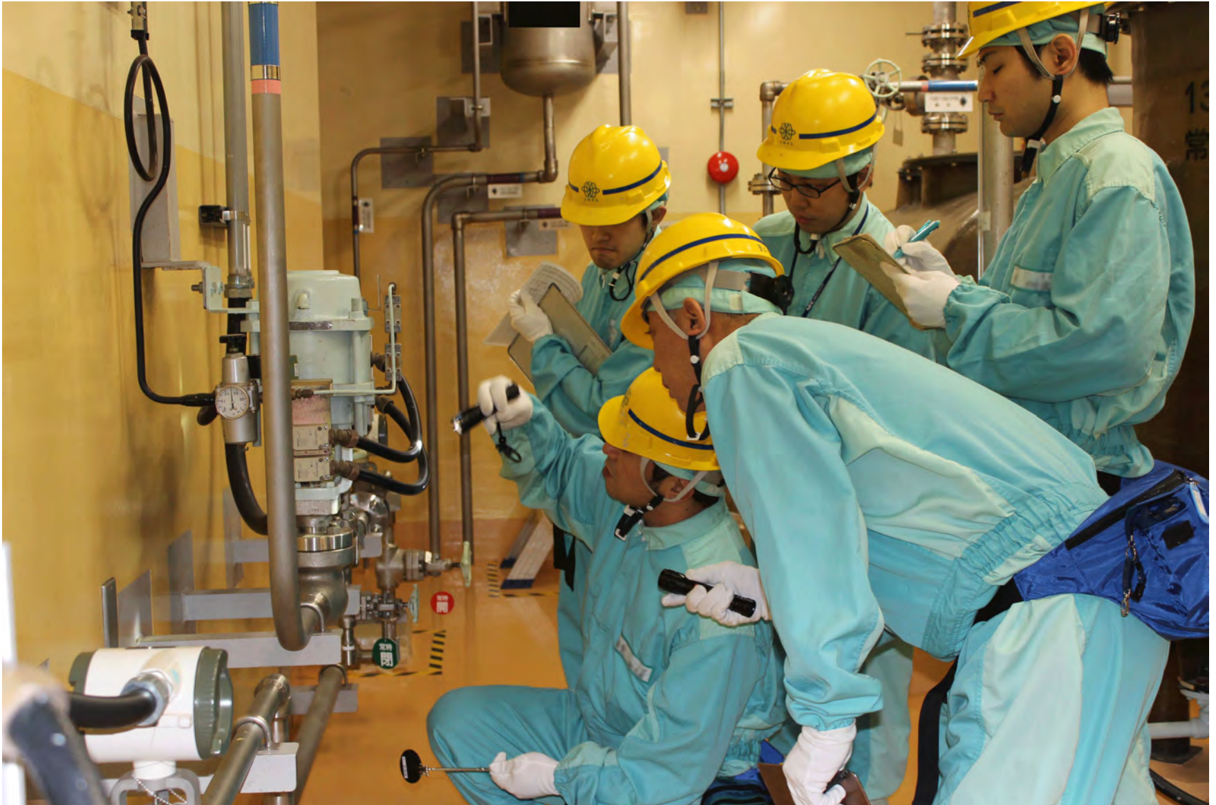
機器類を冷却する設備の確認
