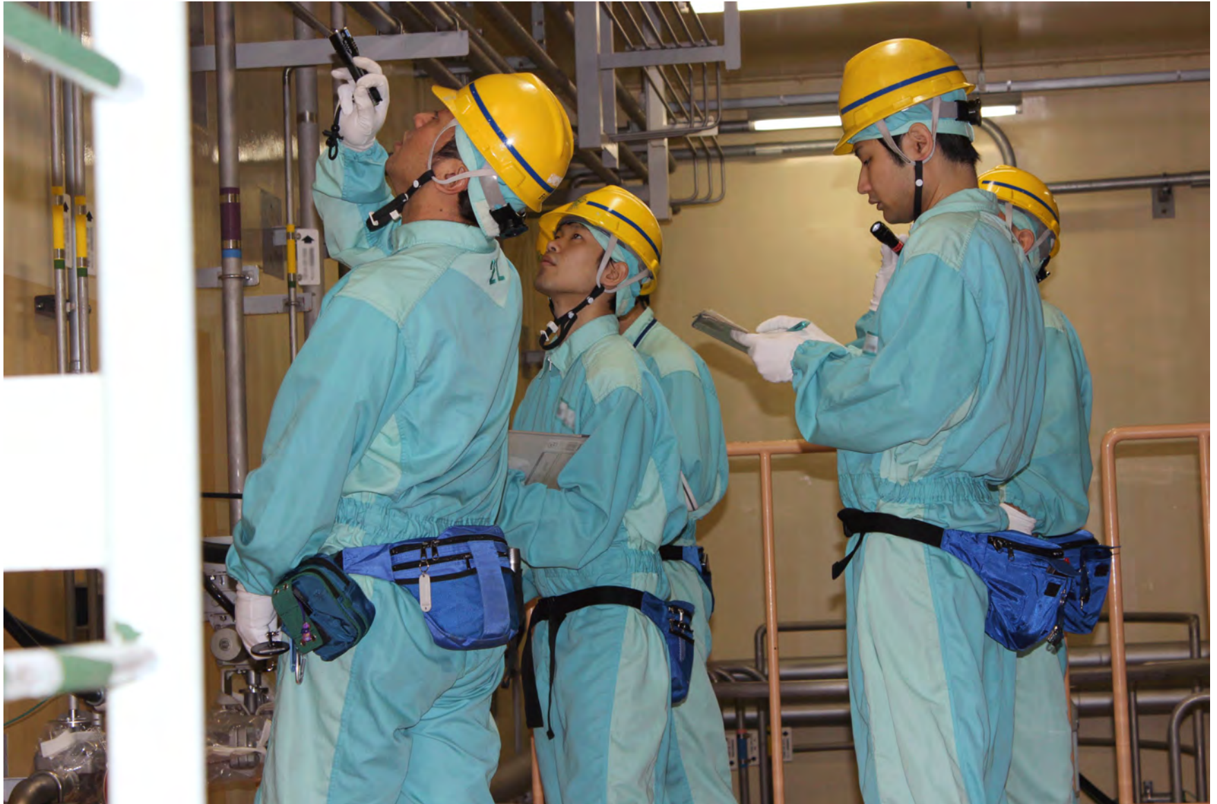
上部に設置されている配管等の確認
