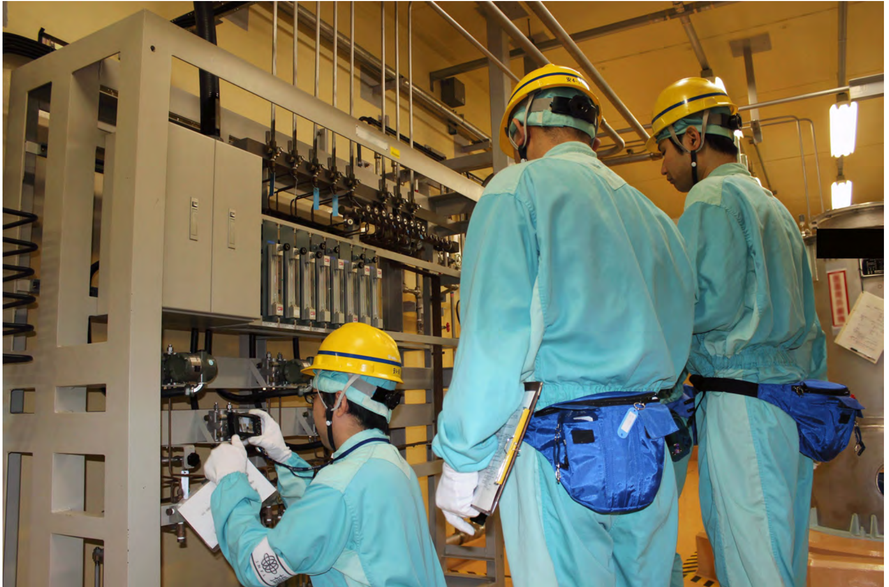
タンクの液位・密度を測定する機器の確認
