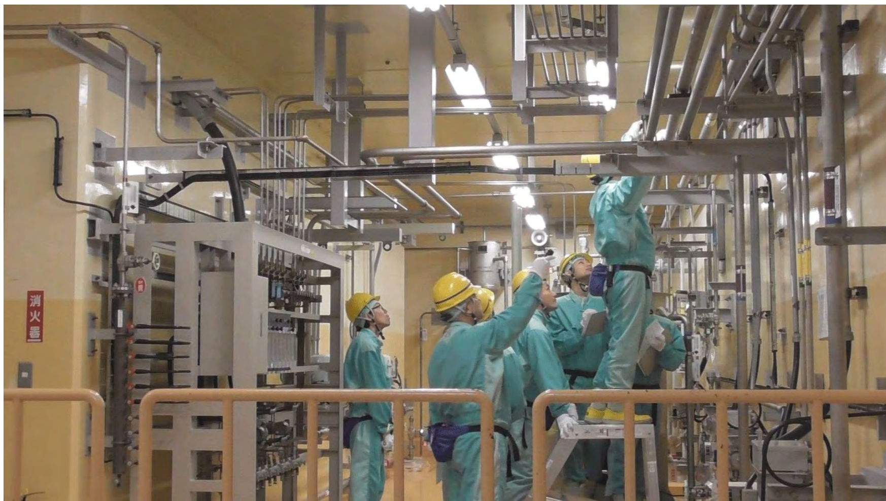
上部に設置されている配管等の確認
